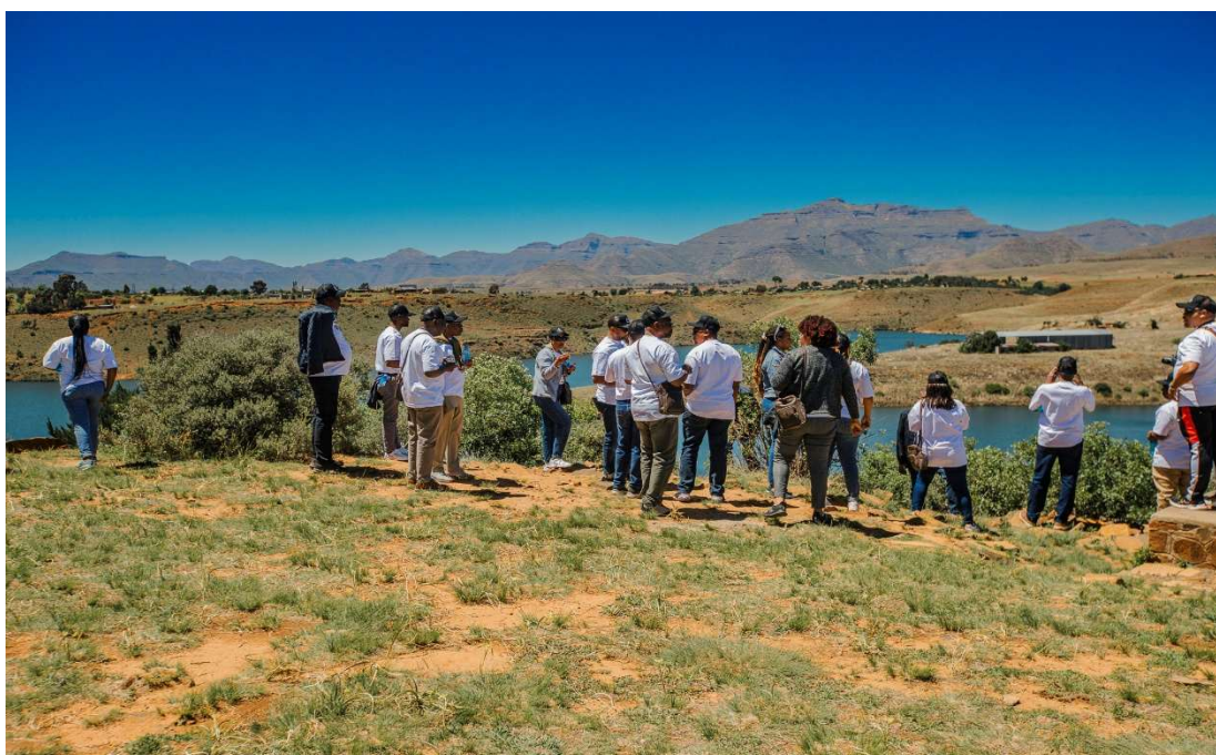
Photo 5 : Les membres de l'ASAFG au barrage de Metolong
