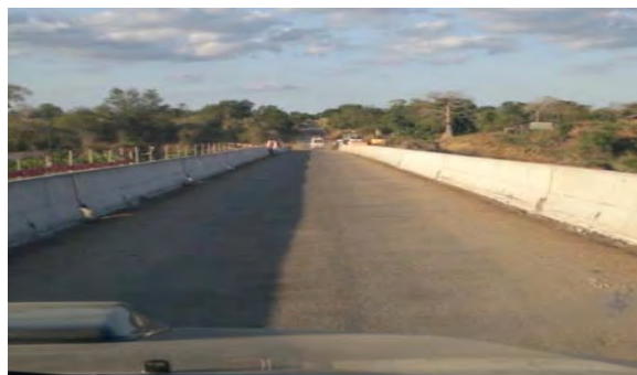
Figura 5.2.1.2(b): N1: Ponte Rio Mecutuchi
